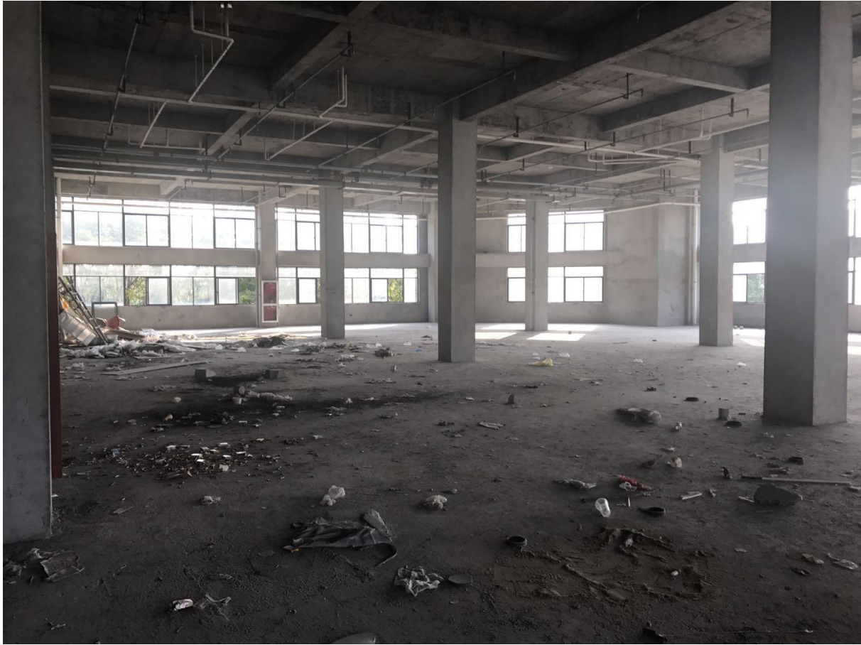
图 1.2-1 项目拟建地厂房现状
